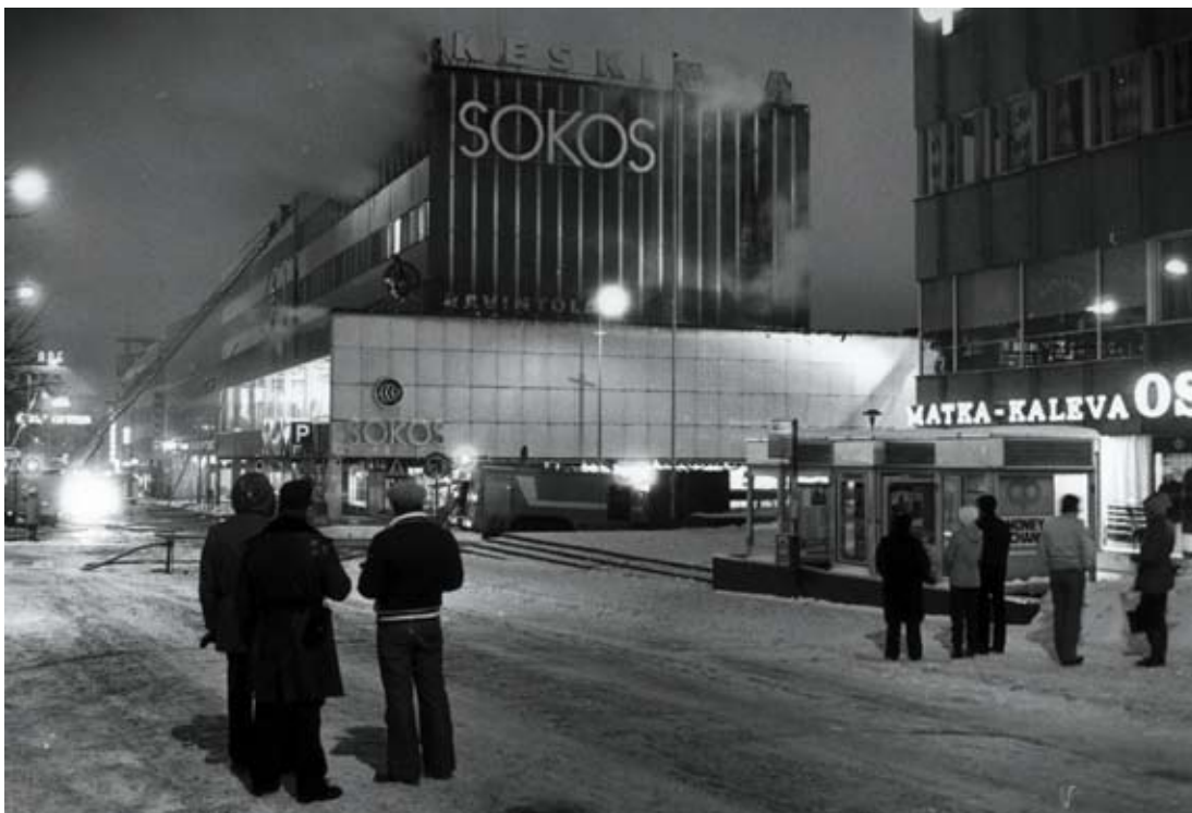
Sokoksen ylimmässä kerroksessa sijainneen ravintola Ukkometson sammutustyöt jatkuivat vielä öistä tulipaloa seuranneena aamuna.
