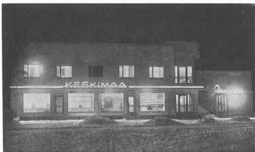
Tikkakosken myymälä- ja ravintolarakennus iltavalaistuksessa.
